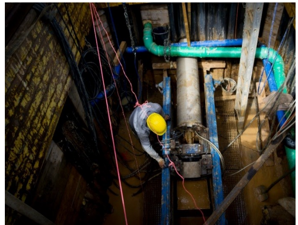
Im Mikrotunnelbau mit Schneckenfördersystem werden die Vortriebsrohre aus Polymerbeton mit Hilfe eines steuerbaren Bohrkopfes zielgenau durch das Erdreich gebohrt.
