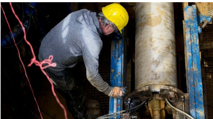
Vortriebstechnik in der geschlossenen Bauweise auf der Baustelle in Wiesbaden.
